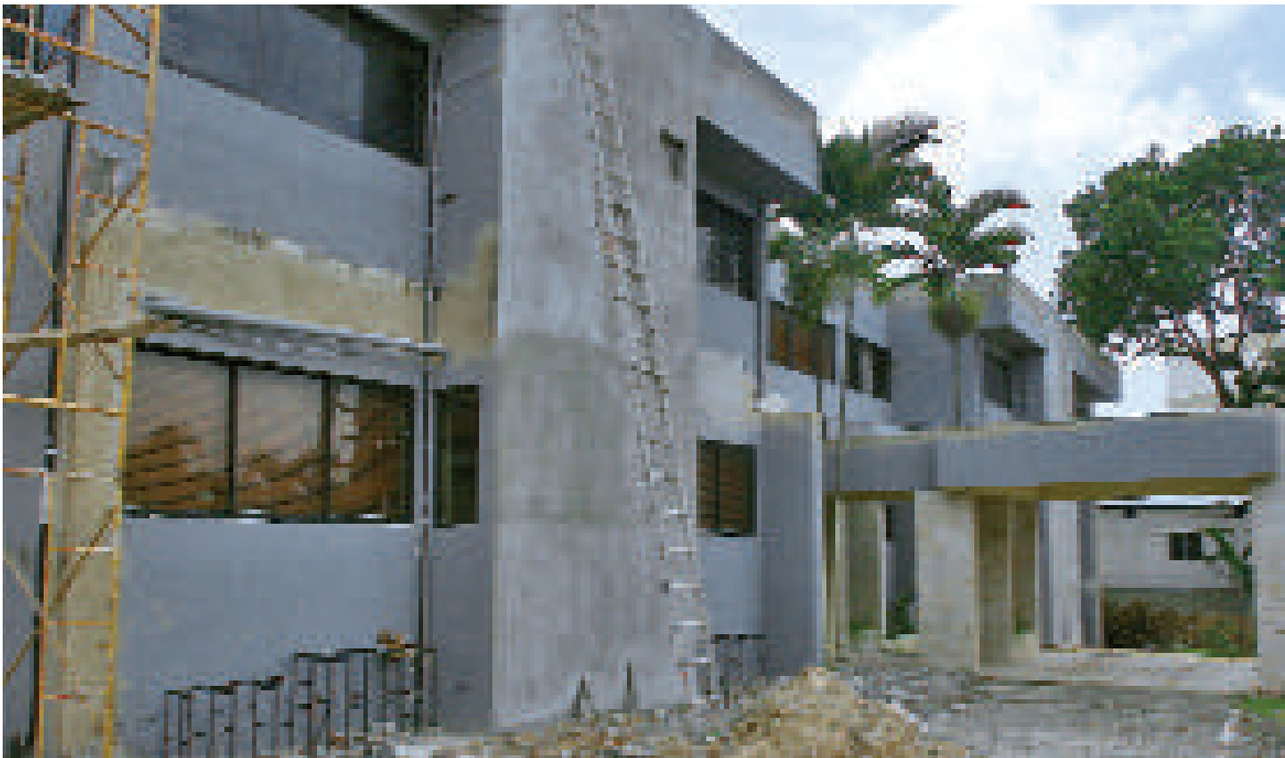
Un aspecto del avance de la construcción del edificio levantado por la ONAPI, para alojar su sede central, en Santo Domingo.
