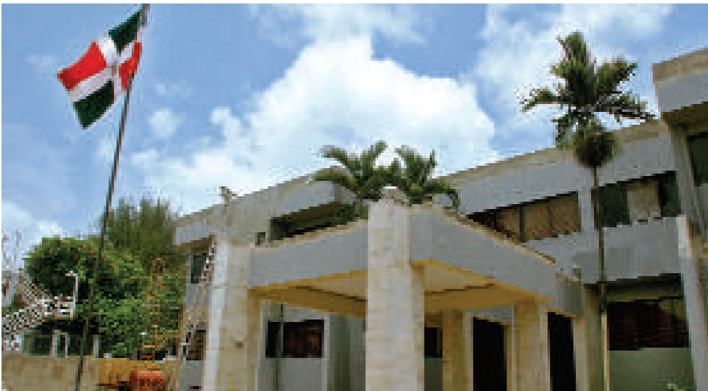
Otro Angulo de la construcción.
