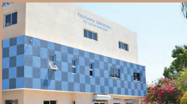
Fachada del nuevo edificio administrativo de la ONAPI en cuya área de archivo se salvaguardan los registros de Signos Distintivos.
